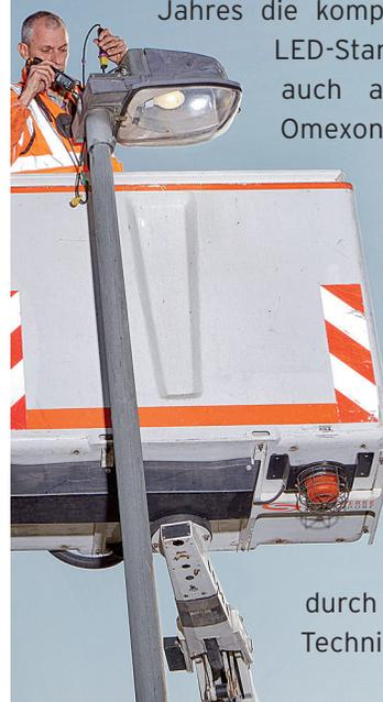
Die Lampenmasten selbst blieben weiterhin bestehen, lediglich deren bisherige Leuchtaufsätze wurden komplett abgenommen und durch die neue, stromsparende LED-Technik ersetzt.
